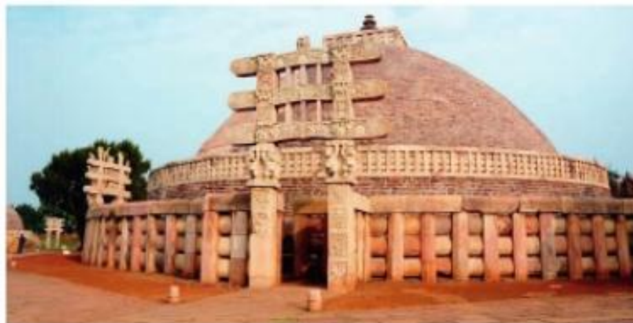
Stupa de Sanchi, templo dedicado a Buda y construido cerca del año 150 a. C.
